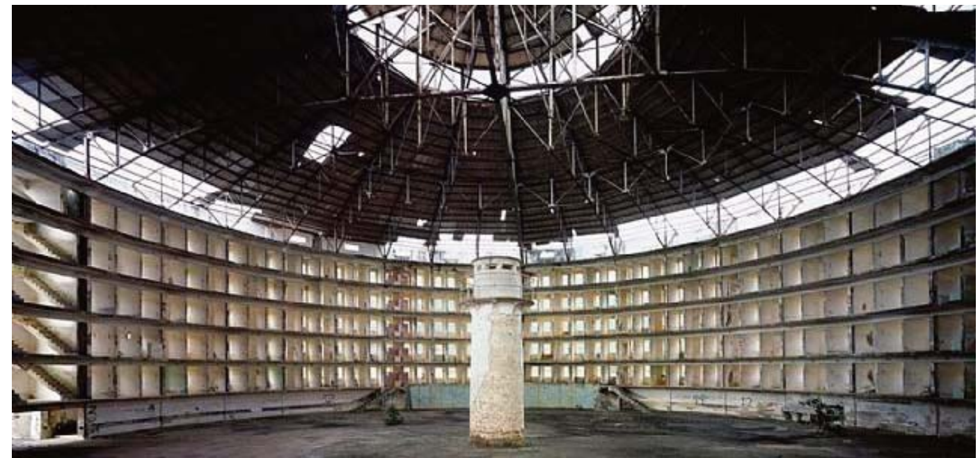
Panoptici del Presidio Modelo sull'isola de la Juventud a sud di Cuba. Costruiti negli anni Venti, oggi sono un museo dopo la dismissione del 1967.
